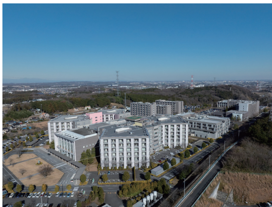
写真 1-1 埼玉医科大学日高キャンパス全景 手前が国際医療センター、右奥が保健医療学部校舎
